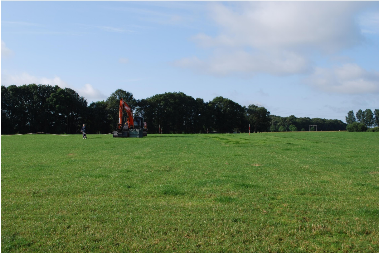
Afbeelding 1.3 Situatie van het terrein voor aanvang van de werkzaamheden. De foto is genomen richting het zuiden. Op de achtergrond loopt het terrein sterk af richting de spoorlijn.
